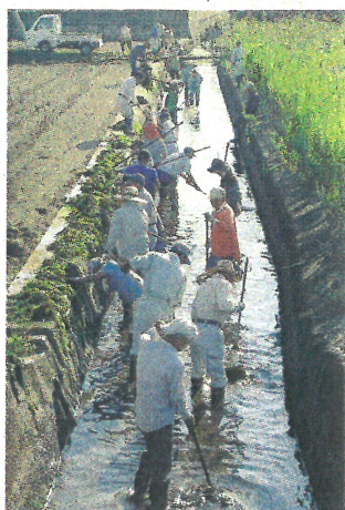
水路の泥上げ作業
